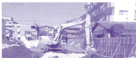
基礎（地盤）工作業時の様子 さいわい診療所 出川
